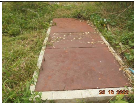
รูปที่ 2 บ่อ Inspection Manhole
